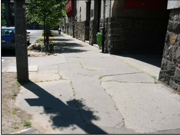
17. kép, 18. kép: A térfal melletti járdák elhasználódtak, töredezettek
