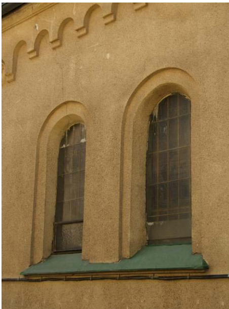
38. kép: repedés az oldalhajó ablaka fölött
