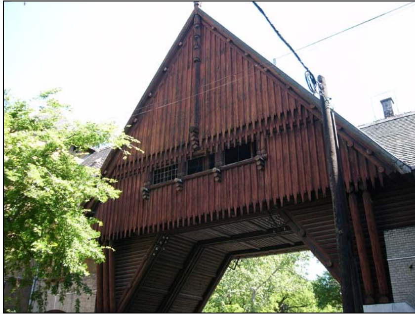
30. kép: A fából épült kapuépítmény az úttest két oldalán álló kőburkolatú pilléreken áll
