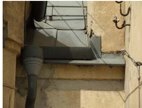
41. kép: vakolathiányok a tetőfelújítás után
