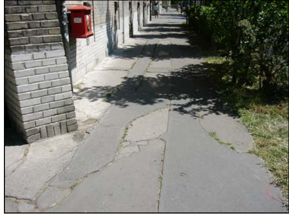
17. kép, 18. kép: A térfal melletti járdák elhasználódtak, töredezettek
